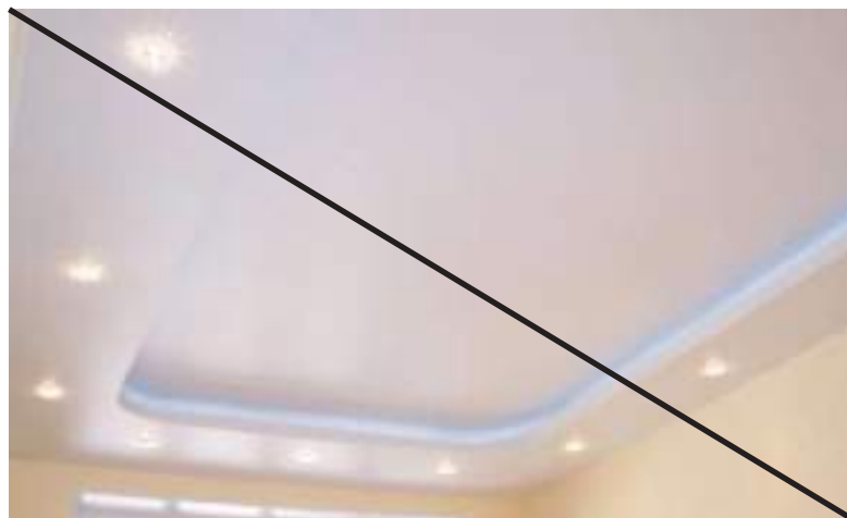
Плохо Многоуровневые гипсокартонные конструкции
